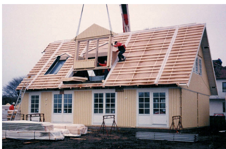
Figur 6: 1½-planshus fabriksstillverkat som två volymelement och tio takelement.
