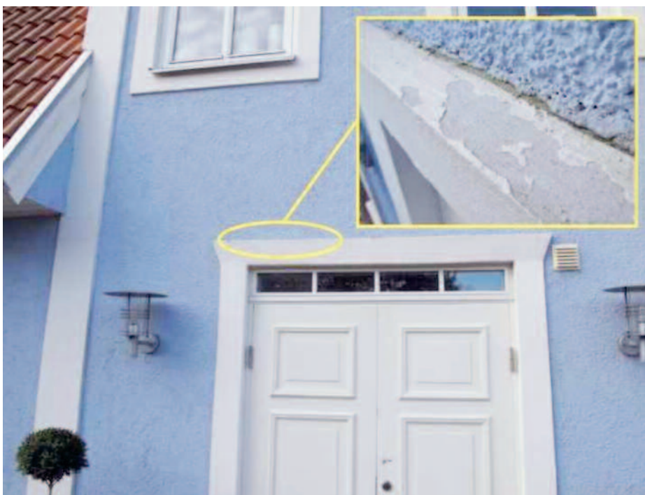
Figur 2: Villa med enstegstätad putsfasad på träregelstomme. Putsen har ett stort antal fina sprickor respektive frostsprängningar runt dörröppning.
