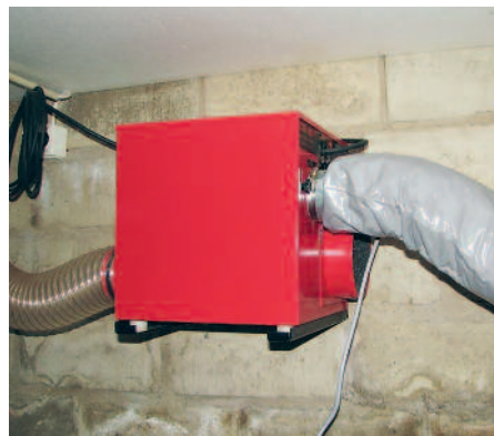
Figur 2: Installation med avfuktare i krypgrund.
