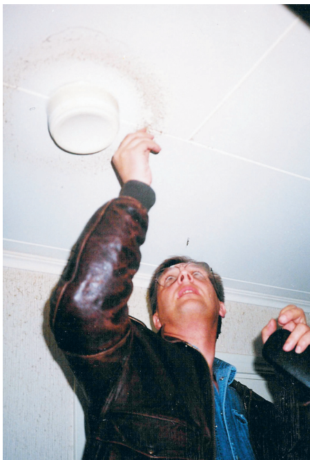
Figur 2: Föroreningar runt tilluftsdon i tak (viss medejektering).
