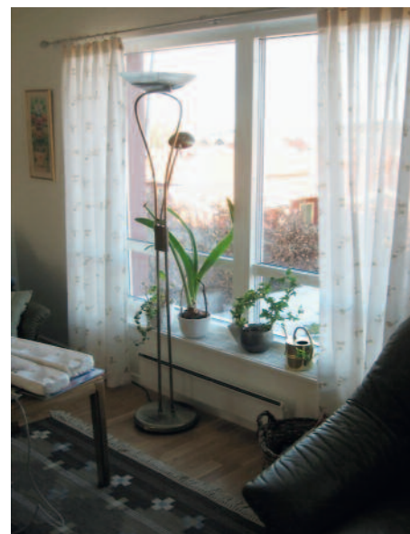
Figur 14: Område 1, passivhus med luftvärme. Komplettering med elradiatorer har måst göras för att uppnå tillräcklig komfort.
