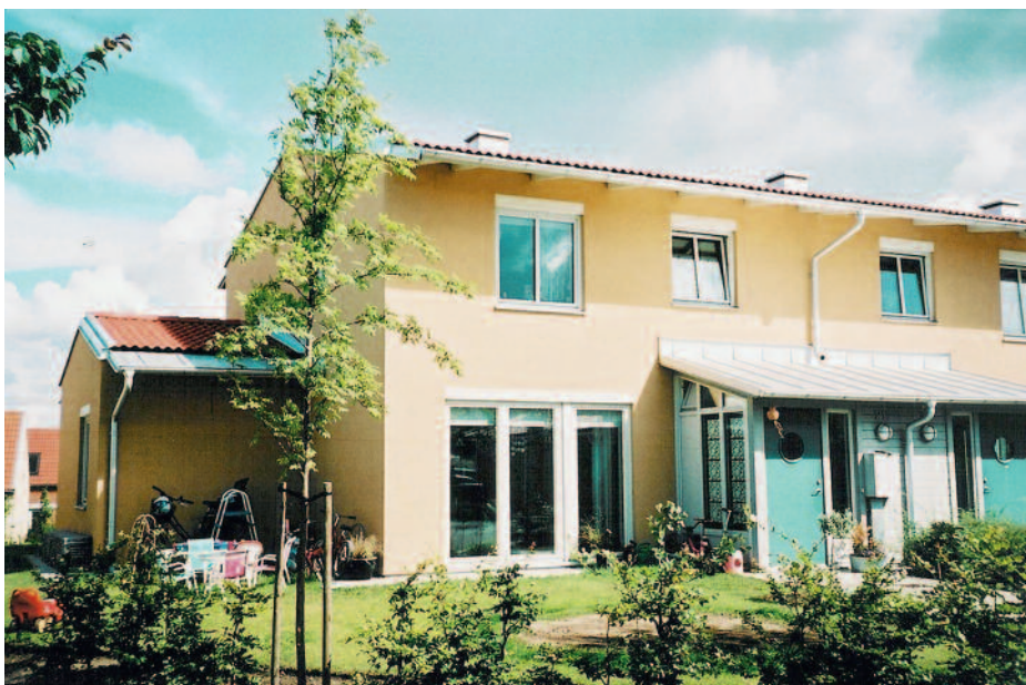
Figur 4: Passivhus i Glumslöv. Bilden är tagen vid höstdagjämningen och mitt på dagen. Fönstren saknar nästan helt solavskärmning på utsidan, vilket lett till oacceptabelt höga innetemperaturer under sommarhalvåret. Vintertid klagar de boende på att det är för kallt i husen.
