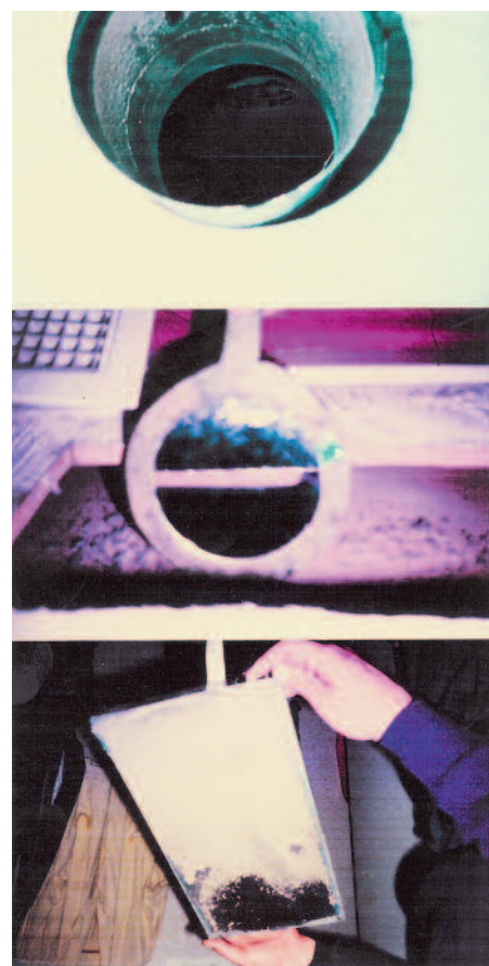
Figur 2: Föroreningar i luftvärmesystem.
