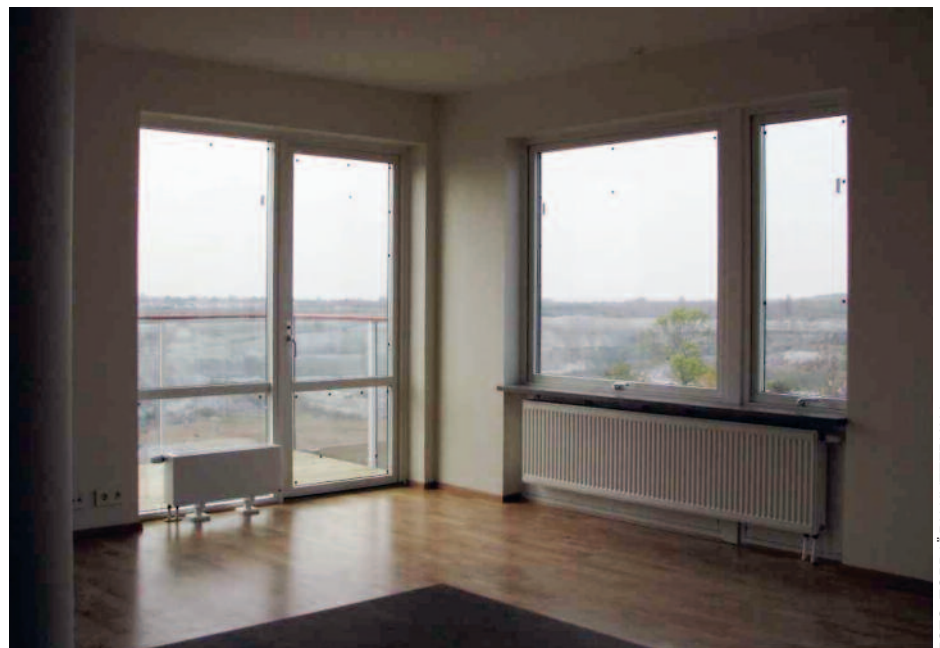
Figur 7: Radiatorer som komforthöjare vid stora fönsterytor.
