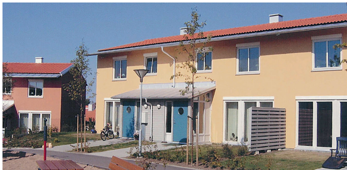
Figur 5: Passivhusen i Glumslöv. Solavskärmning den 23 september 2005 kl 13.15. Glasytor i bottenvåningen är helt oskärmda. Foto: Torbjörn Klittervall.
