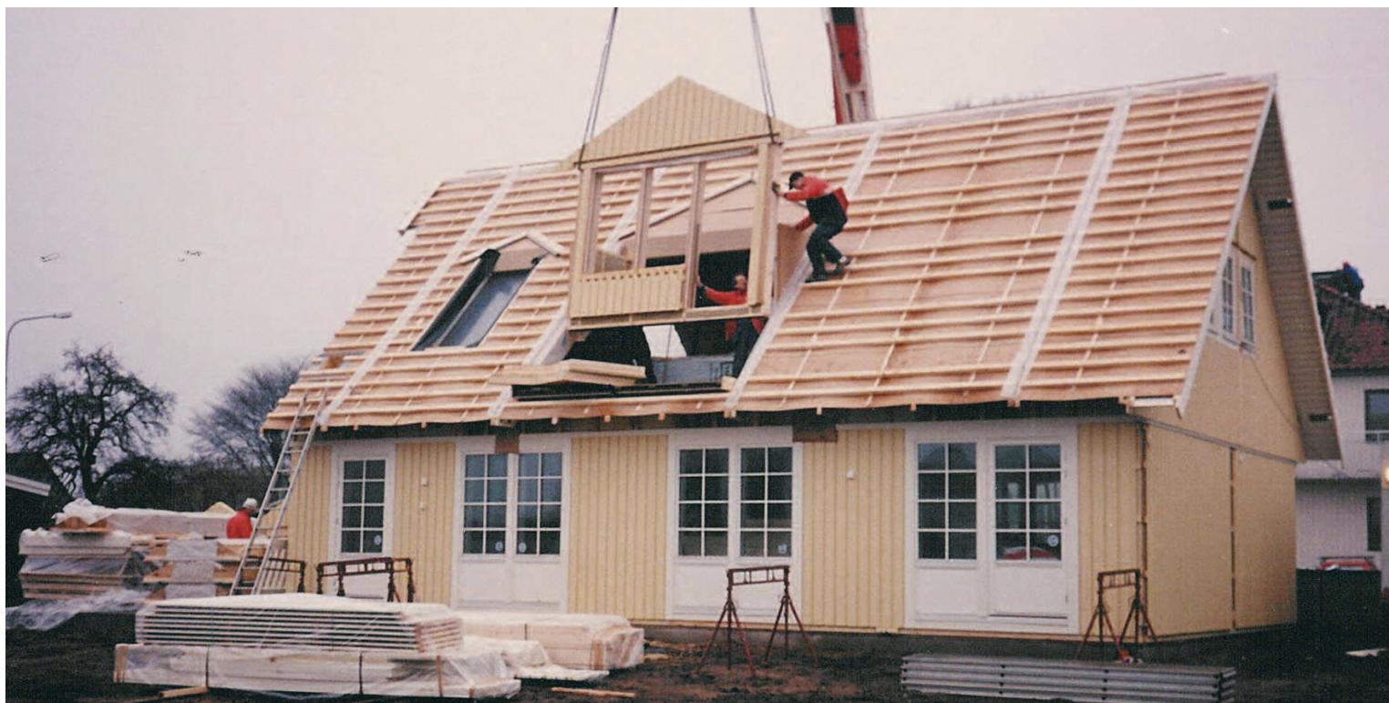
Bygge av hus med låg energianvändning. Foto: Christer Harrysson
