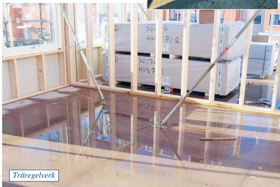
Figur 1: Syllar och träregelverk är extremt utsatta för fukt under husets hela livslängd.
