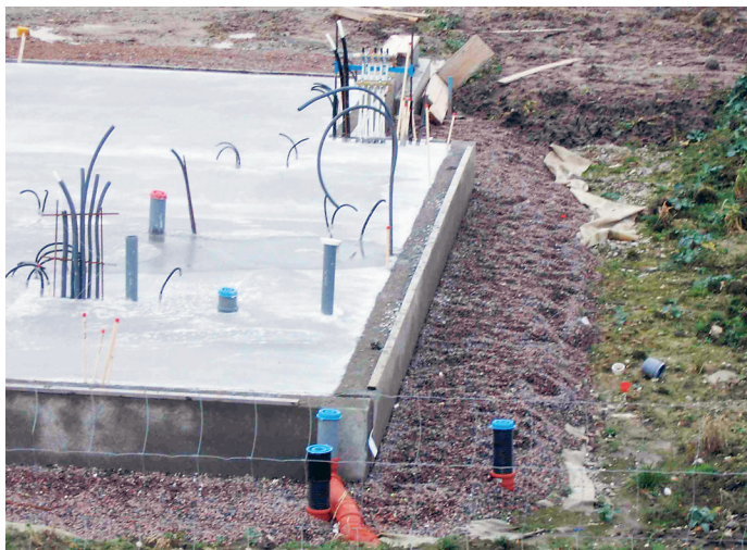
Figur 2: Husgrund med vanlig platta på mark-konstruktion.
