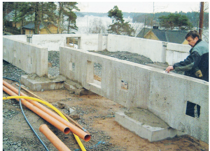
Figur 3: Krypgrund av betongkonstruktion, Tranemogrundern.
