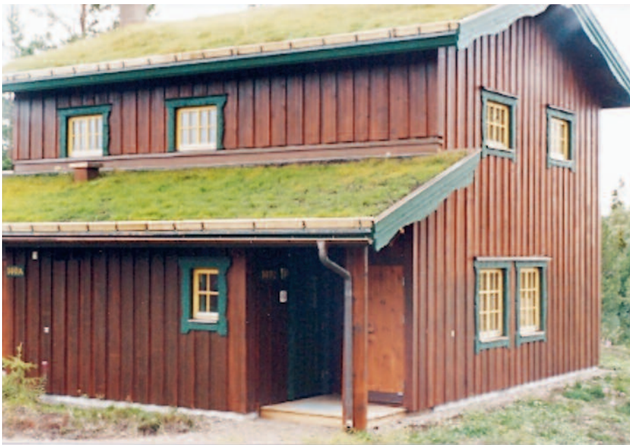
Figur 9: Villa i Sälen med små fönsterytor.
