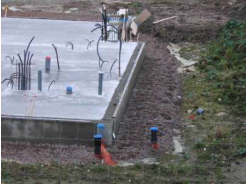
Figur 2. Husgrund med vanlig platta-på-mark-konstruktion. Foto: Torbjörn Klittervall.
