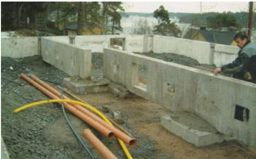
Figur 3. Krypgrund av betongkonstruktion, Tranemogrundern. Källa: Tranemo G-betong.
