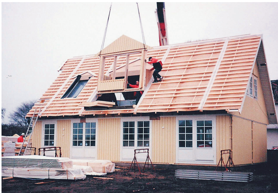
Figur 4: Ett och ett halvplanshus förtillverkat som två volymelement och yttertak med mera som storblock.
