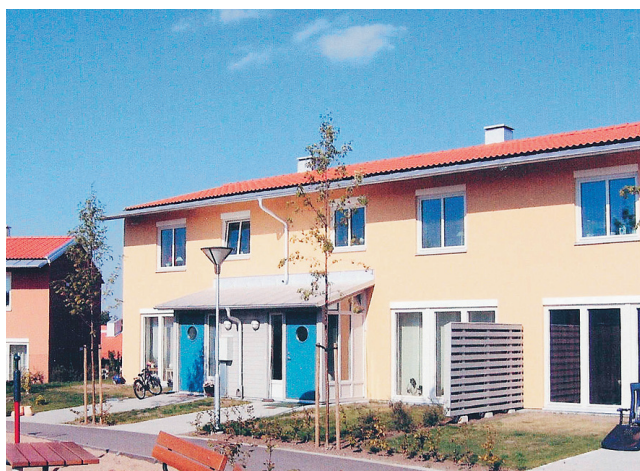
Figur 5: Passivhus i Grumslöv. Solavskärmning 23 september 2005 klockan 13.15. Glasfönster i bottenvåningen är helt oskärmda.
